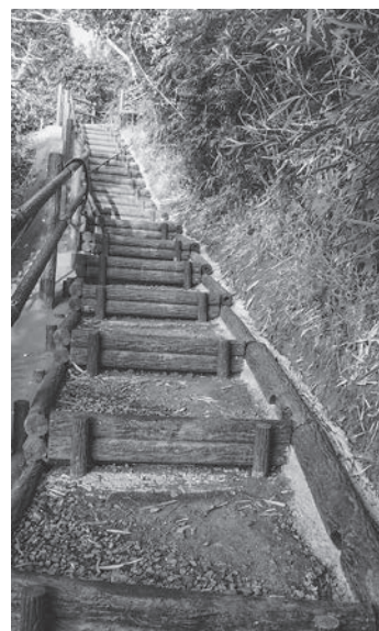
改修工事後の参道
