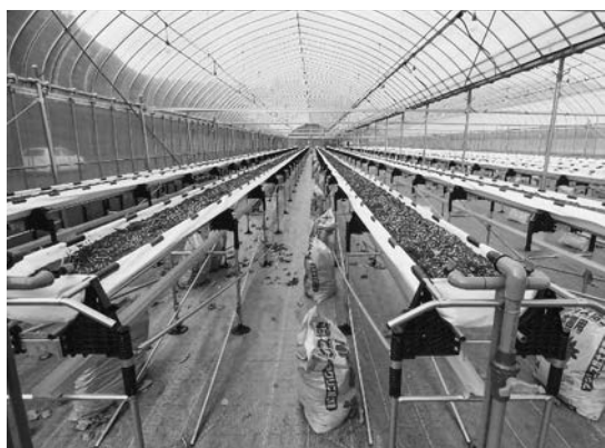
完成したトレーニングハウス
